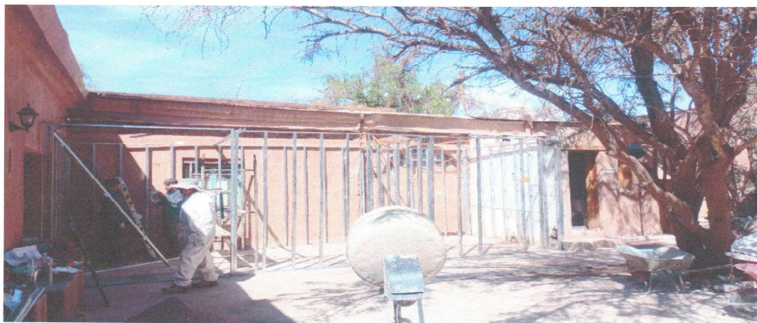
AVANCE DE OBRAS DESAM Sistema modular metalcon estructural.
